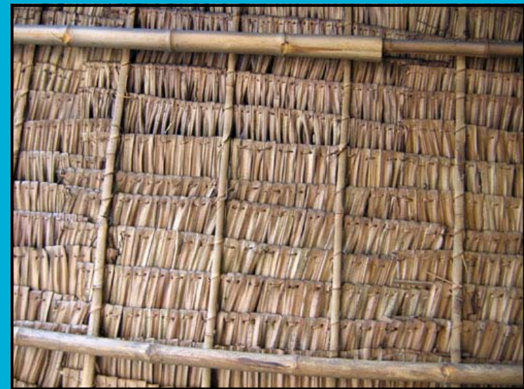
Palmenblattschindeldach von innen
